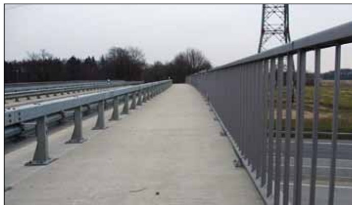
Radweg auf der Brücke über die A7
