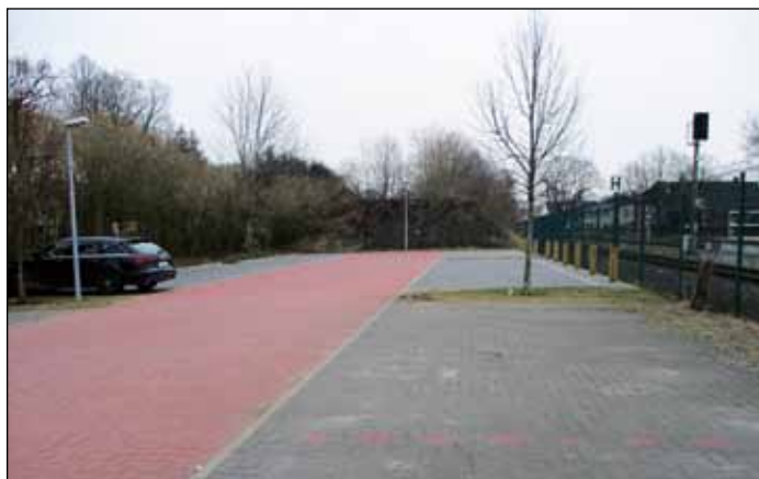
Parkplatzerweiterung am Bahnhof Ellerau
